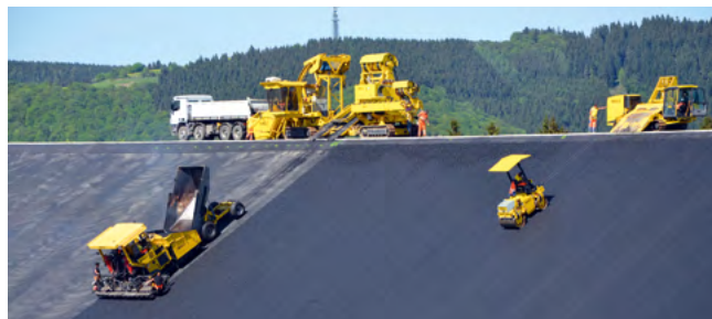
2018: Von Grund auf saniert – das Oberbecken wird asphaltiert.
