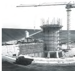
1967: Bau des Einlaufturms
